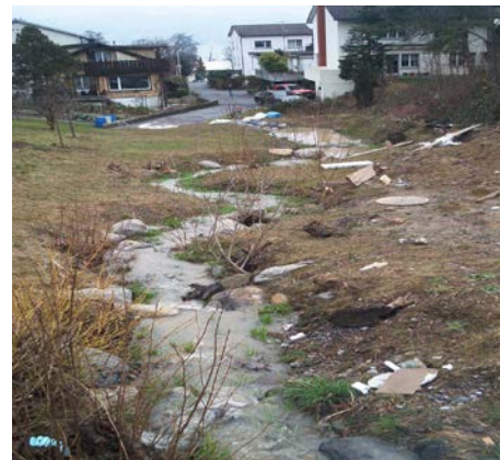
Rietlibach 1 Jahr nach der Bachöffnung
